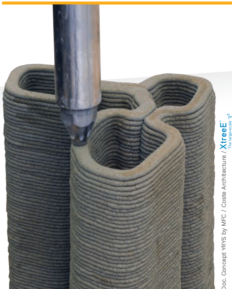
Poteaux extérieurs en impression 3D par Lafarge et XtreeE.
