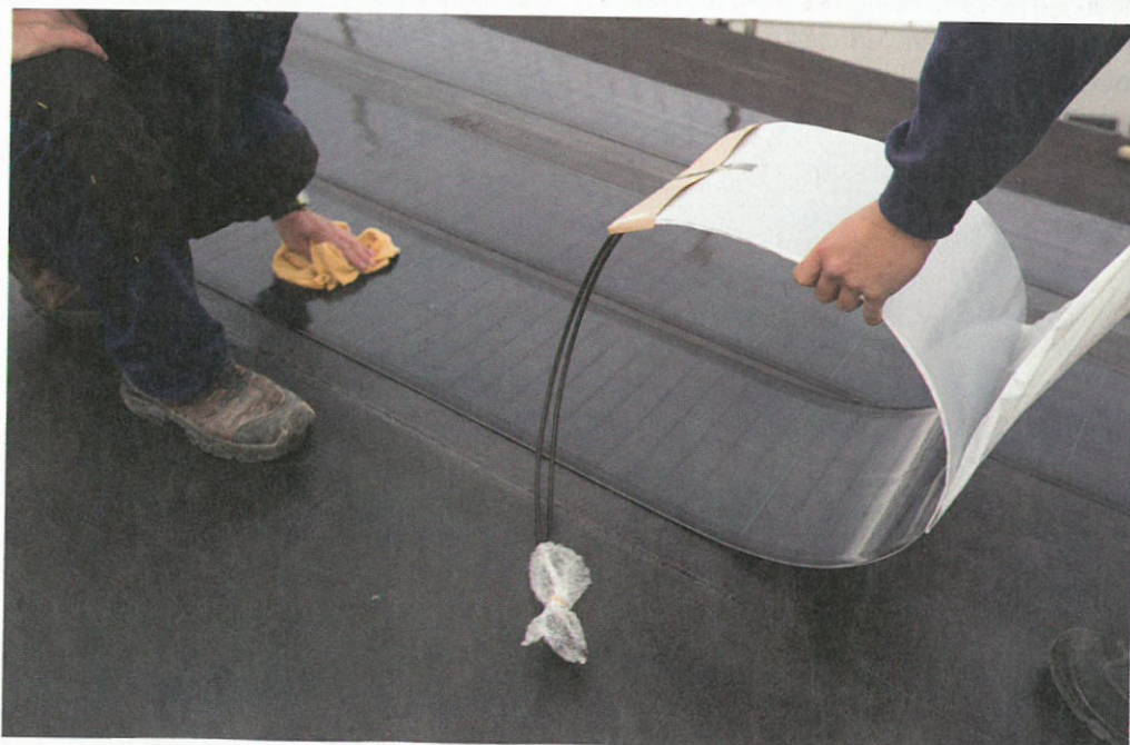
Sur le toit du Concept Yrrys, Soprema installe une membrane photovoltaïque.
